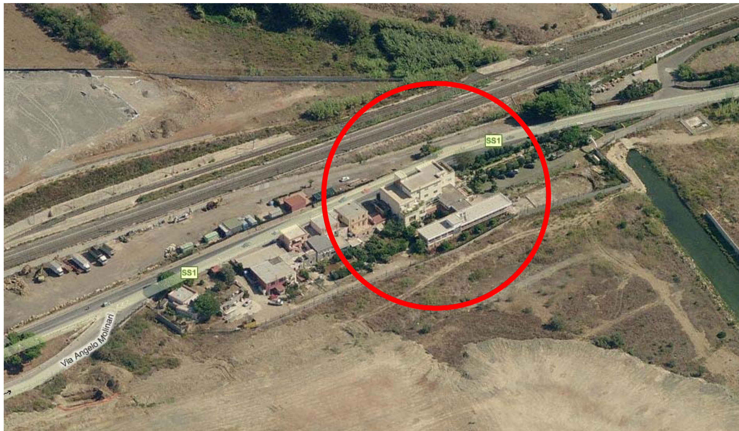
Zona 5 - edifici lungo Via Aurelia, lato Ovest, compresa la casa di riposo S. Rita
